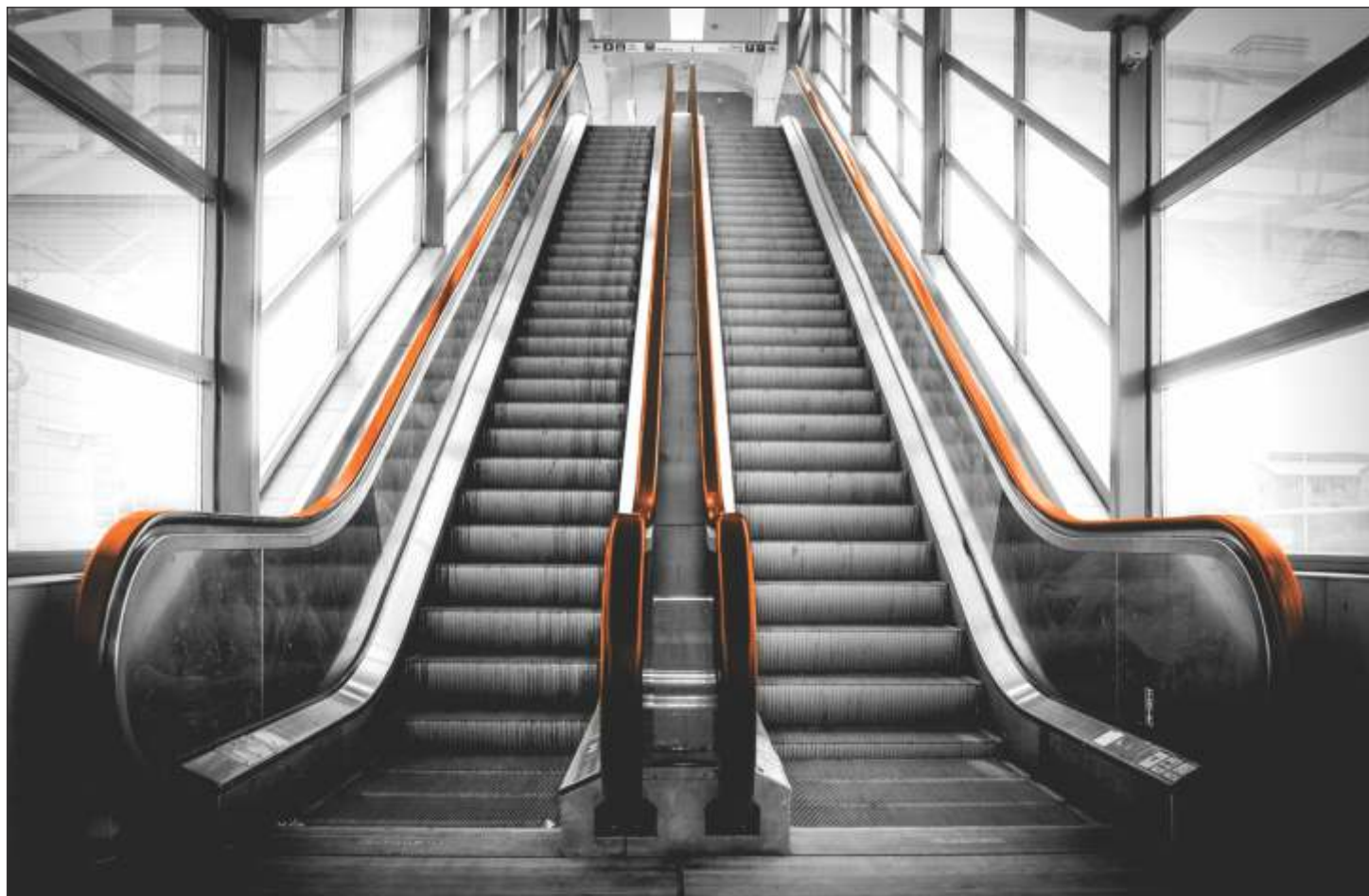
Scările rulante care vor fi instalate în pasajul CFR vor fi de ultimă generație
